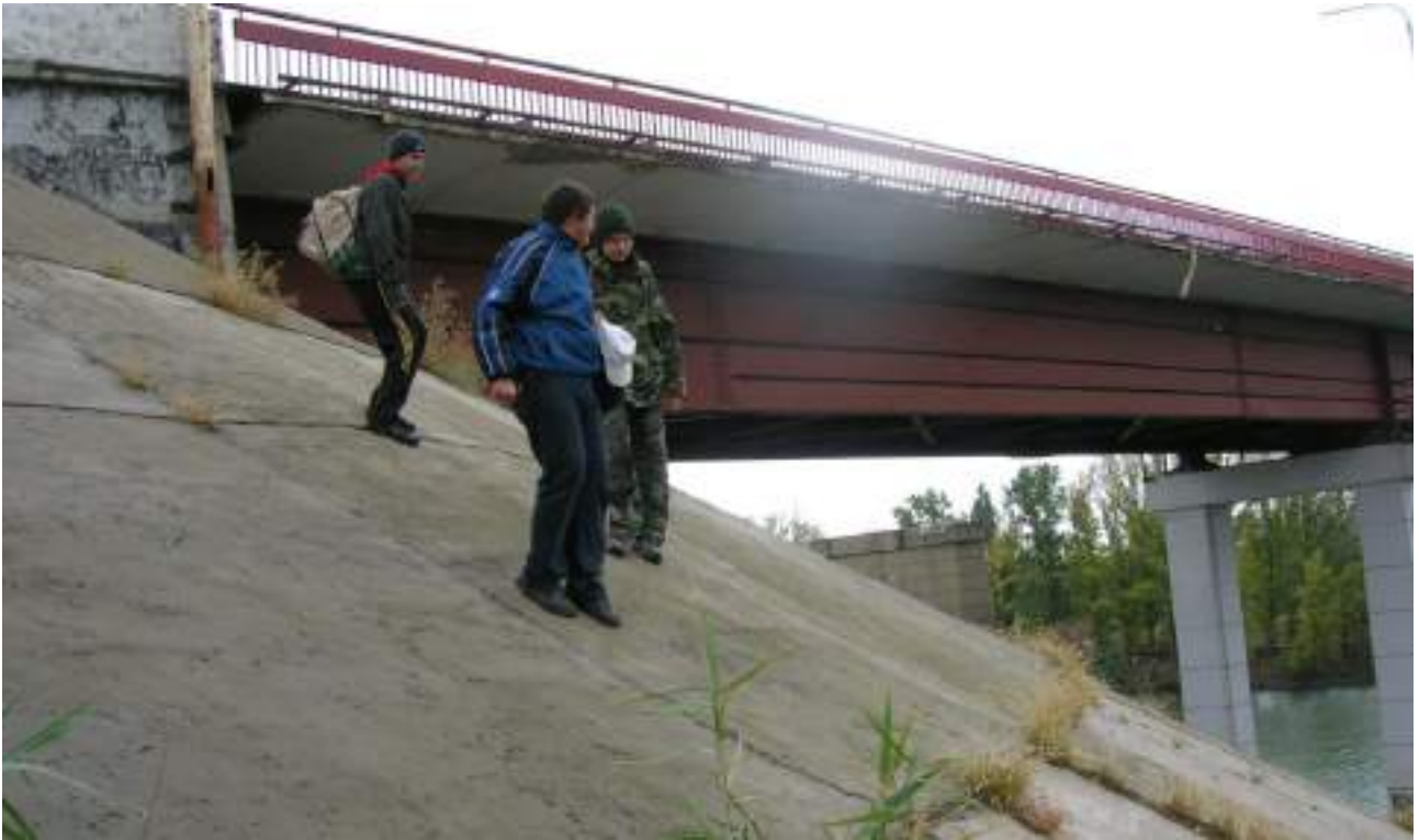
Фото 4. Спуск по бетонной плоскости. На заднем плане видна опора старого моста (3 октября 2010 года)
